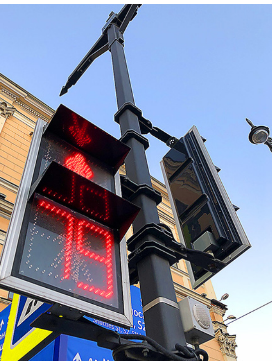
Устройство звукового и голо- сового сопровождения зеленого сигнала пешеходного свето- фора с сигналом ориентации – «ТРИОЛЬ»
